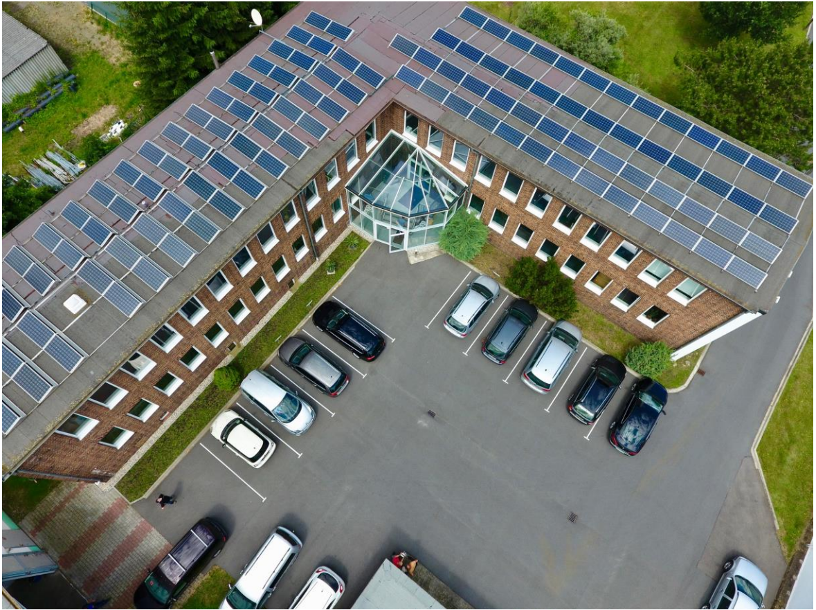
Abbildung 2: PV-Dachanlage auf Bürogebäude der ifn-Anwenderzentrum GmbH
