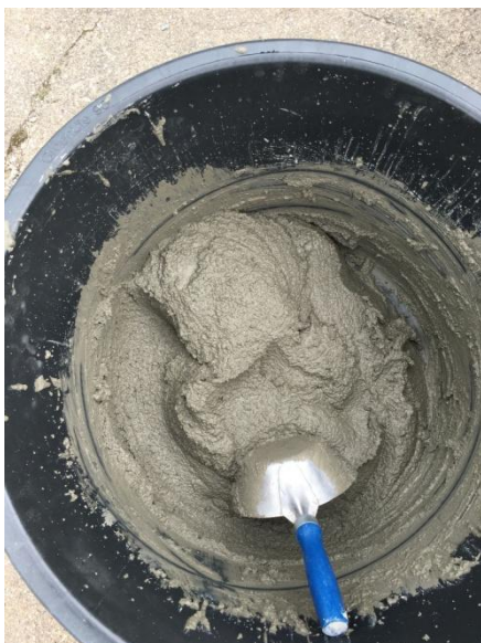
Abbildung 1 Mischung einschichtige Innenwandlösung
